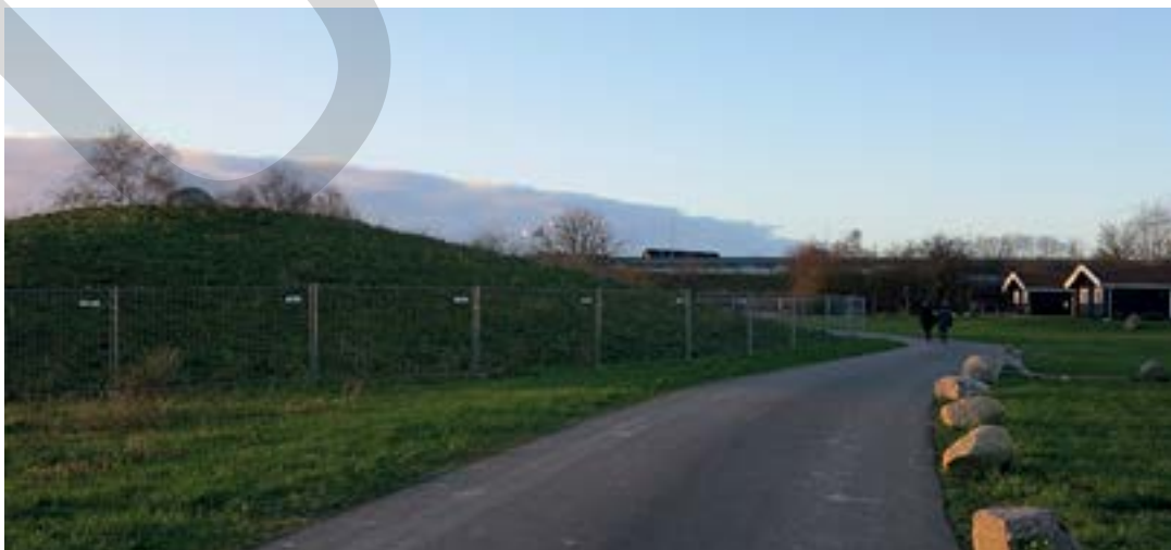
Nyt bassin ved Symfonivej
